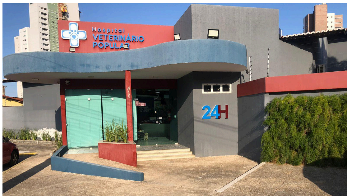
Figura 1 - Fachada do Hospital Veterinário Popular de Mossoró.
