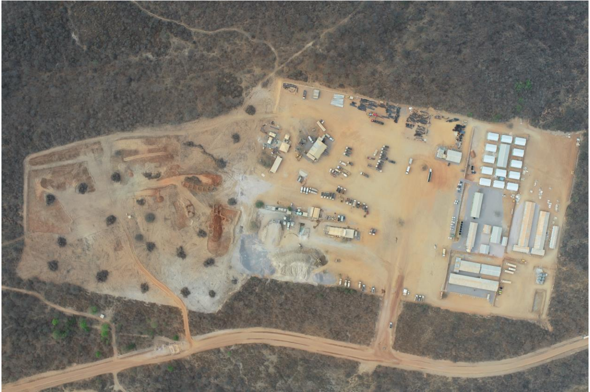
Figura 16 – Canteiro de obras em execução Fonte: Empresa (A)
