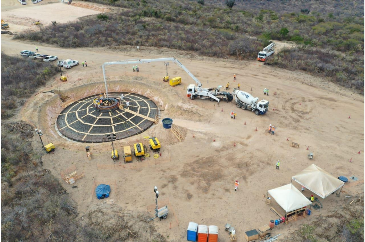
Figura 17 – Atividade de concretagem de base Fonte: Empresa (A)
