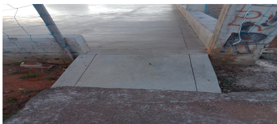
Figura 15. Rampa da entrada da quadra. (Autoria própria)
