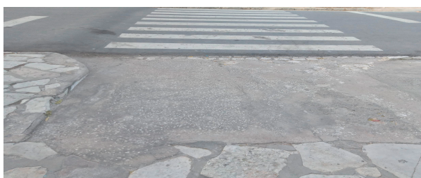
Figura 4. Rampa do rebaixamento da calçada. (Autoria própria)
