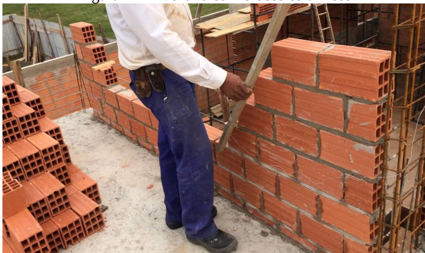
Figura 4 – Alvenaria com blocos cerâmicos
