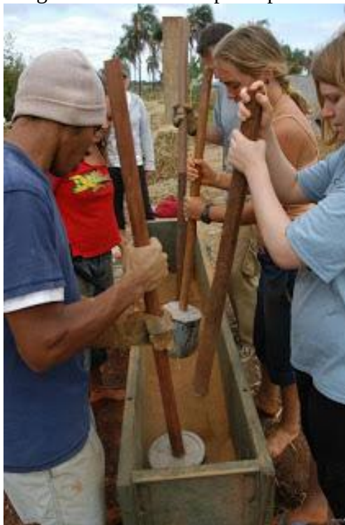
Figura 1 – Técnica taipa de pilão
