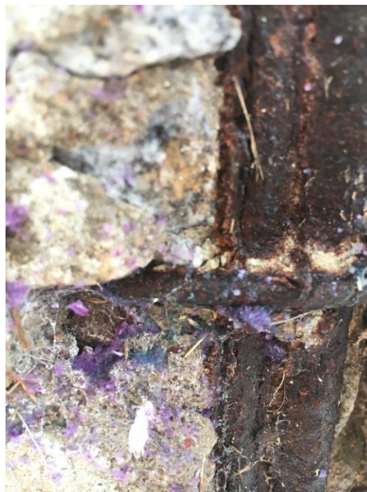
Figura 18 - Pilar com Carbonatação detectada Figura 17 - Detalhe de carbonatação
