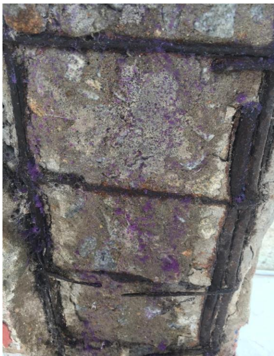
Figura 18 - Pilar com Carbonatação detectada Figura 17 - Detalhe de carbonatação
