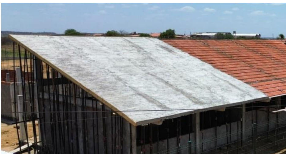
Figura 12 - Imagem gerada por drone para inspeção de laje
