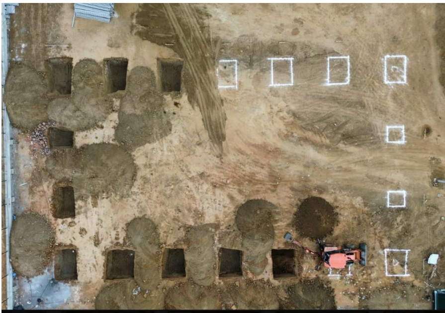
Figura 11 - Imagem com drone para organização de fundação
