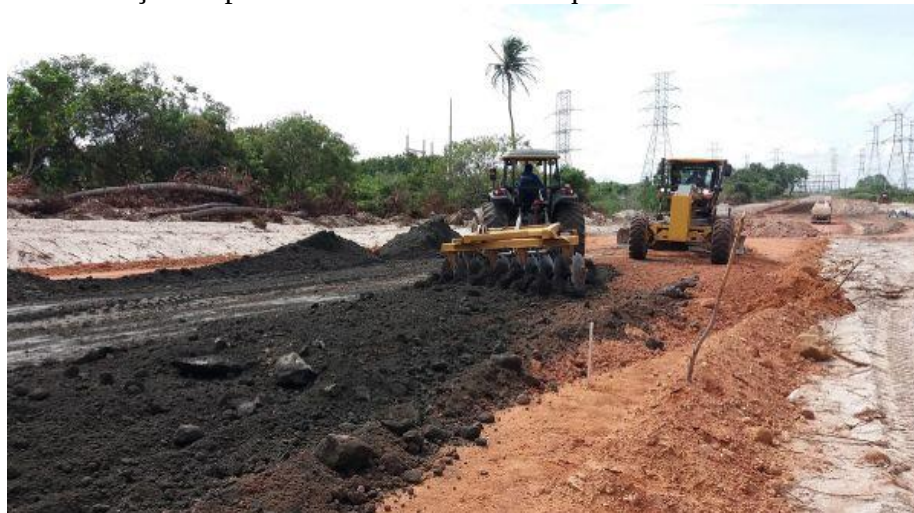
Figura 9 – Construção da primeira estrada do Ceará que reutiliza cinzas de carvão mineral
