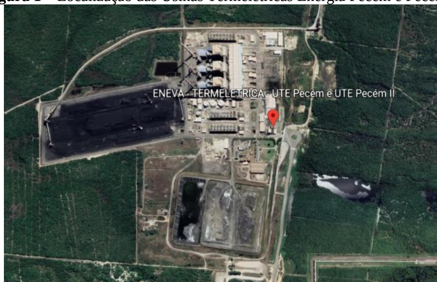
Figura 1 – Localização das Usinas Termelétricas Energia Pecém e Pecém II
