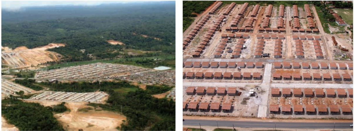
Figura 10: Exemplo de construções habitacionais em Campinas-SP e Manaus-AM com escolhas de terrenos em áreas de expansão.
