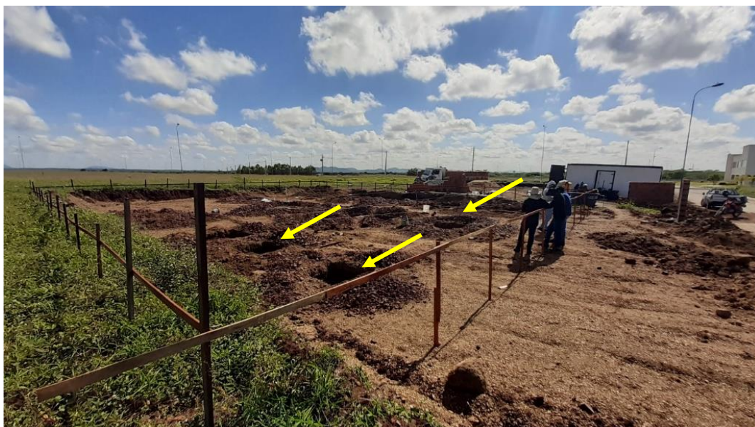
Figura 4.7 Abertura para execução das fundações
