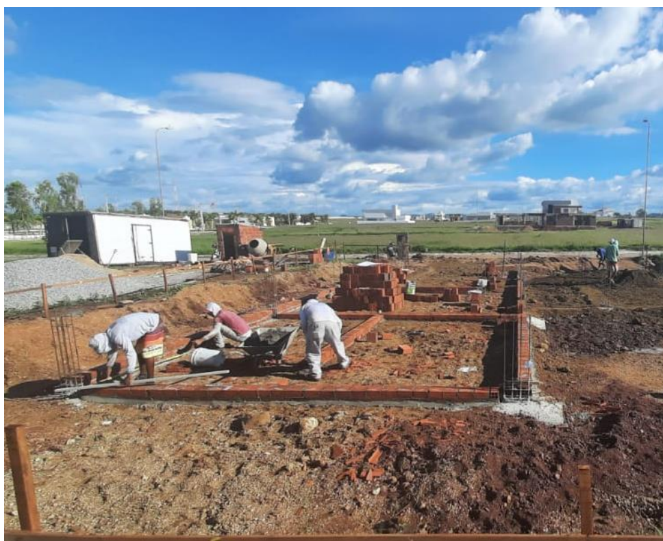
Figura 4.8 Abertura para execução das fundações
