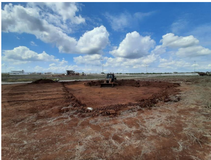
Figura 4.4 Limpeza do Terreno
