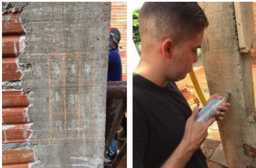
Figura 8 - Ensaio de esclerometria realizado em pilar.
