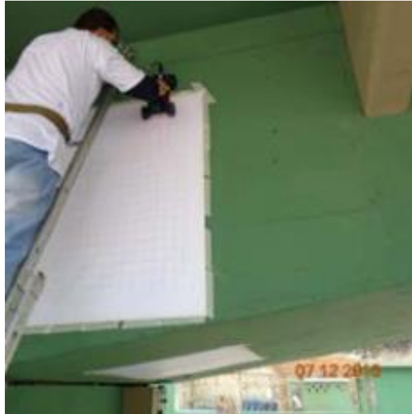
Figura 22 – Aplicação do GPR em viaduto.
