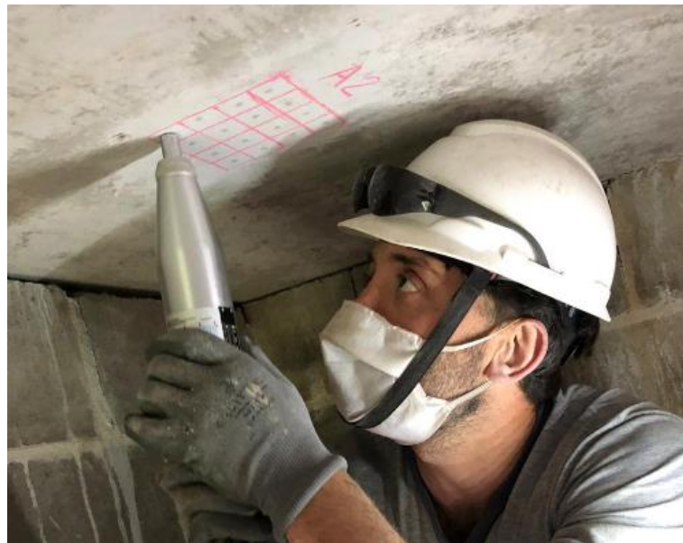
Figura 30 - Ensaio de esclerometria na face inferior de uma laje
