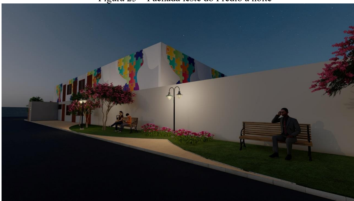
Figura 25 – Fachada leste do Prédio à noite
