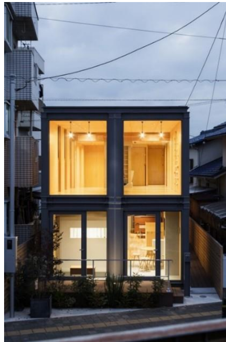
Figura 8 - Fachada principal do centro de apoio Kiitos Hamura
