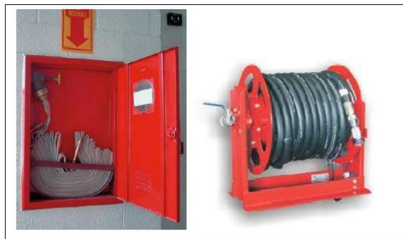
Figura 8 - Sistema de proteção por hidrante e mangotinhos
