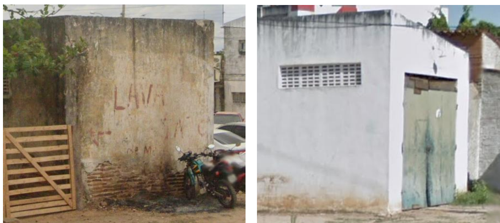
Figura 53 - Fachada posterior e frontal respectivamente da antiga oficina
