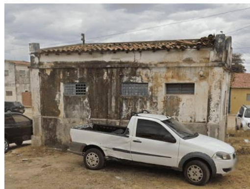
Figura 47 - Fachada posterior do depósito
