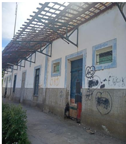
Figura 5 - fachada Posterior da estação ferroviária
