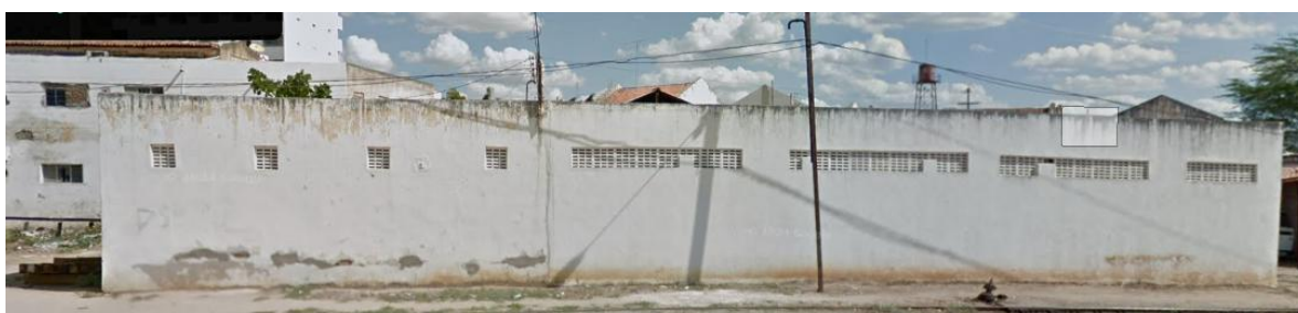
Figura 54 - Fachada lateral da antiga oficina do conjunto ferroviário
