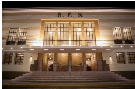
Figura 56 - Prédio atual da estação ferroviária de Caruaru - PE
