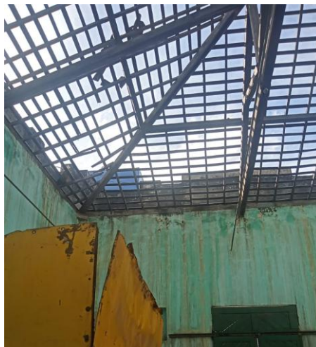
Figura 50 - Cobertura interna da Estação ferroviária
