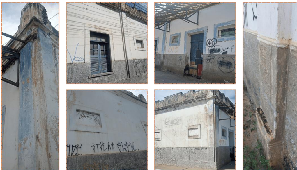
Figura 45 - Detalhes das fachadas da estação ferroviária
