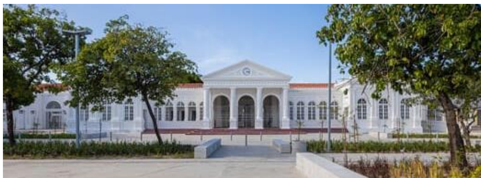
Figura 72 - Fachada principal da estação das artes
