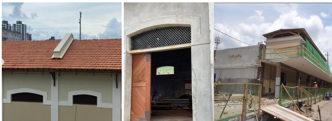
Figura 59 - Elementos construtivos durante a obra
