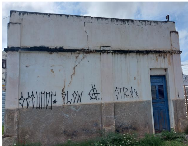
Figura 6 - fachada Frontal do depósito
