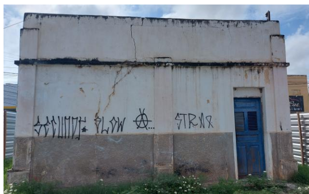
Figura 46 - Fachada frontal do depósito
