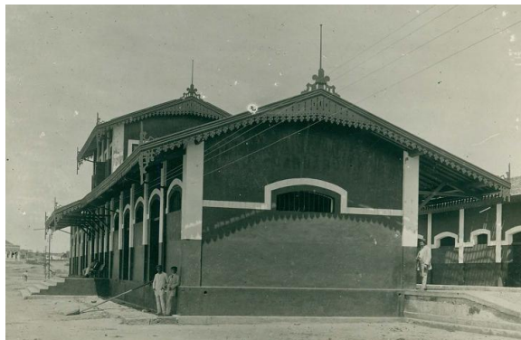
Figura 55 - Primeira estação ferroviária de Caruaru - PE
