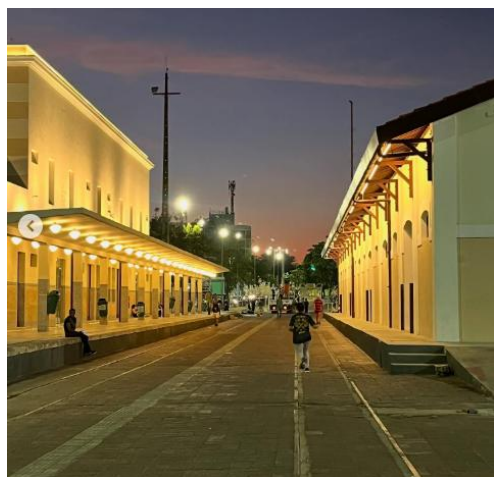
Figura 61 - Área externa do complexo ferroviário e pátio.
