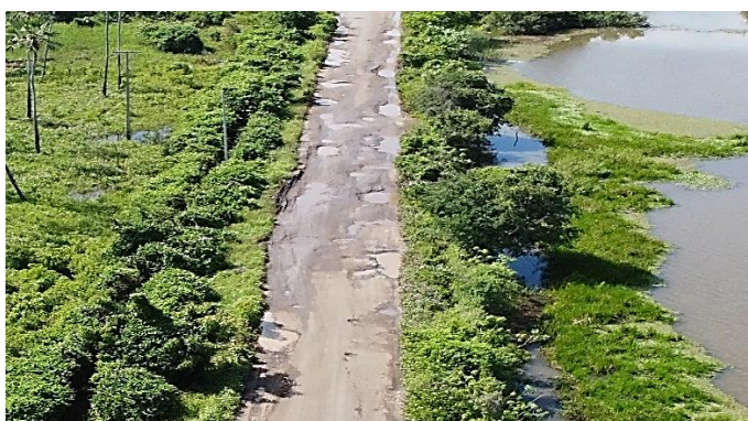
Figura 27: Registro do trecho no ano de 2021
