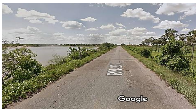
Figura 26: Registro do trecho no ano de 2019
