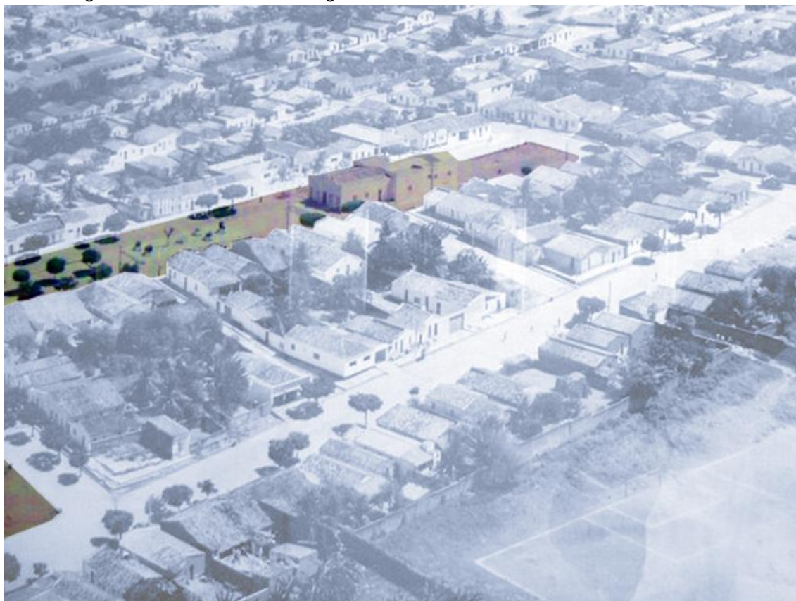
Figura 12 – Vista aérea da antiga malha urbana do centro da cidade – Ano 2002
