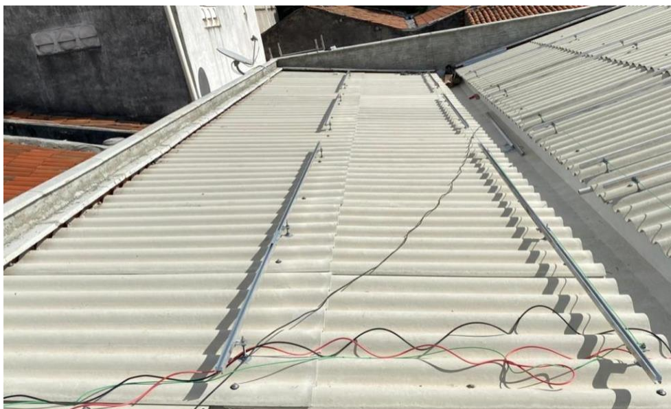
Figura 19 – Kit de fixação sendo montado para receber as placas solares.
