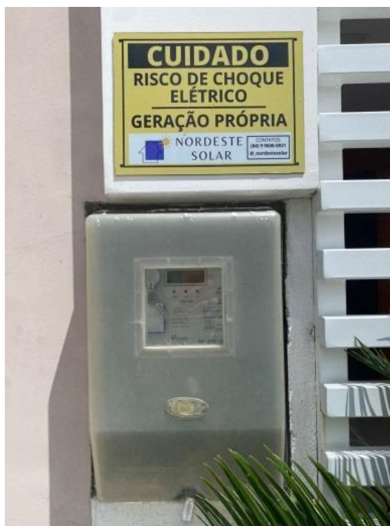
Figura 21 – Medidor bidirecional do imóvel.
