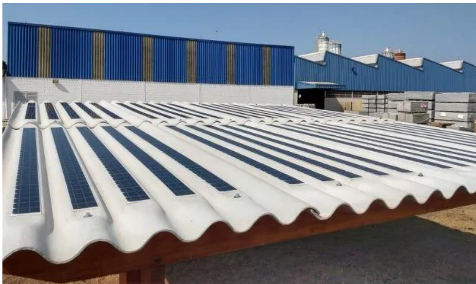
Figura 20 – Fixação telha Eternit.
