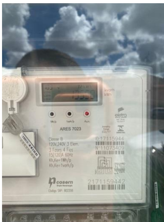
Figura 22 – Medidor bidirecional do imóvel.
