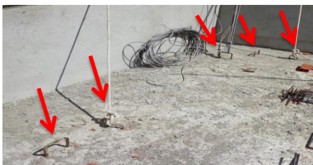
Figura 27 – Pontos de ancoragem temporários fixados na obra analisada
