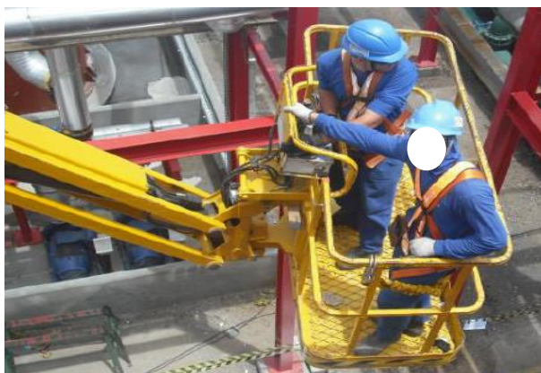
Figura 6 – Plataforma de trabalho
