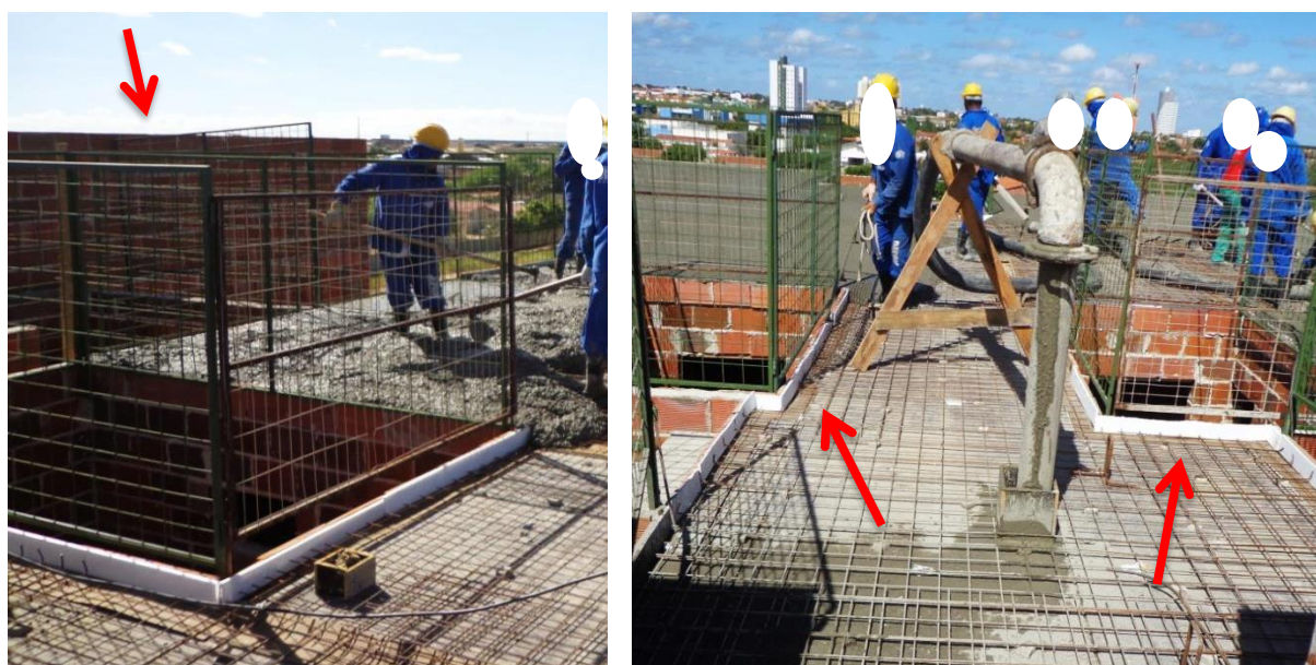
Figura 19 – Aberturas no piso utilizadas para transportar materiais e equipamentos na obra analisada
