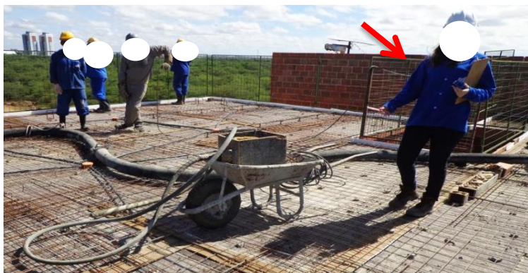
Figura 16 – Supervisão durante a concretagem na obra analisada
