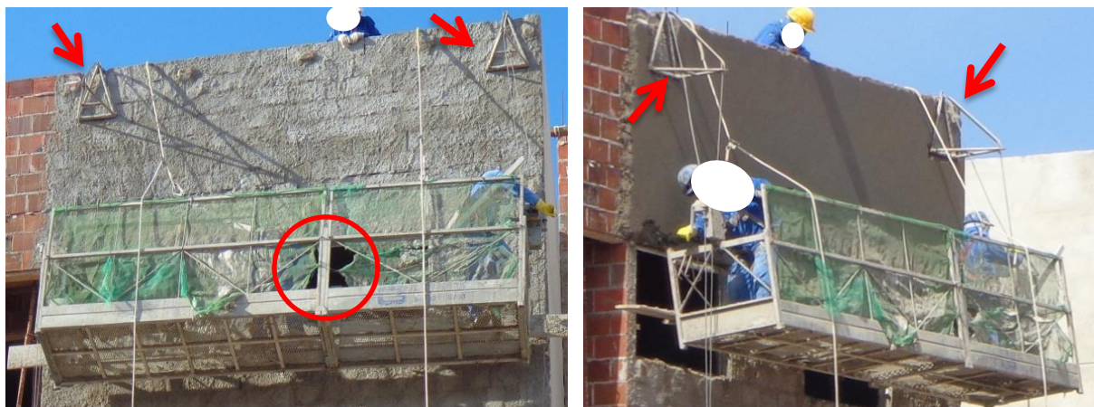
Figura 24 – Jaú utilizado na obra analisada
