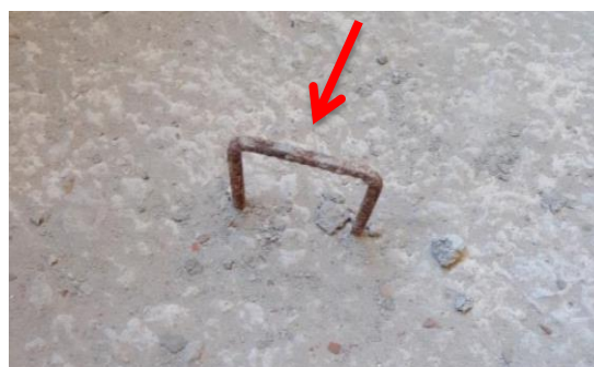
Figura 27 – Pontos de ancoragem temporários fixados na obra analisada
