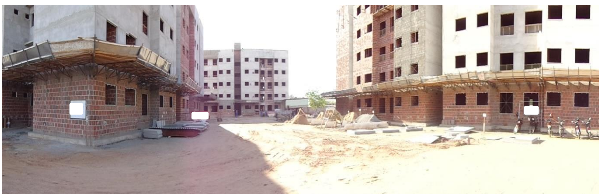
Figura 13 – Visão geral dos 3 blocos de apartamentos da obra analisada
