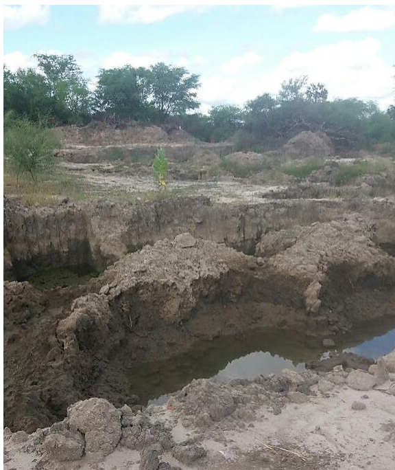
Figura 4.1: Jazida para retirada da argila.
