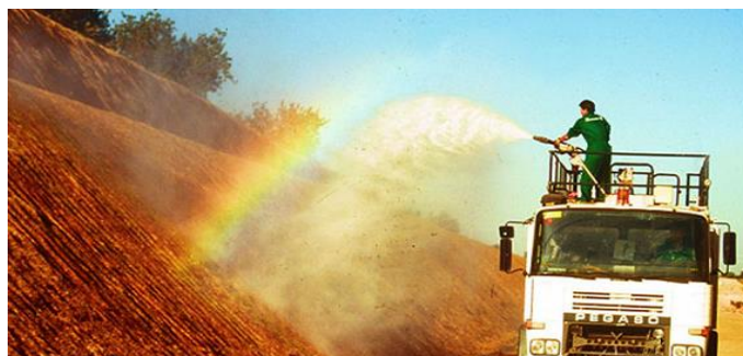
Figura 13 - Hidrossemeadura
