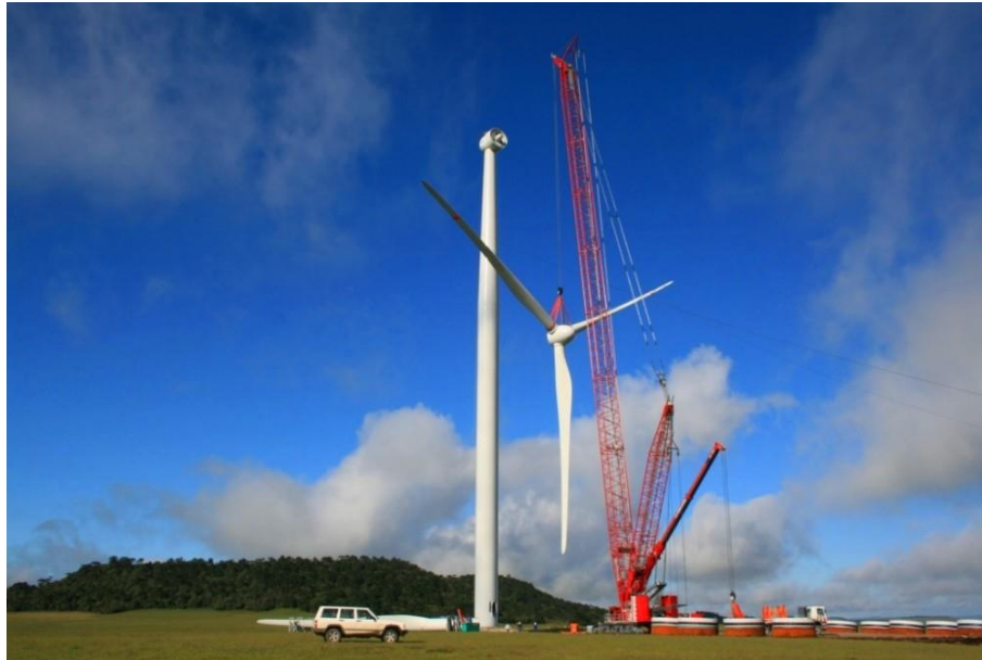
Figura 20 - Torre eólica em montagem
