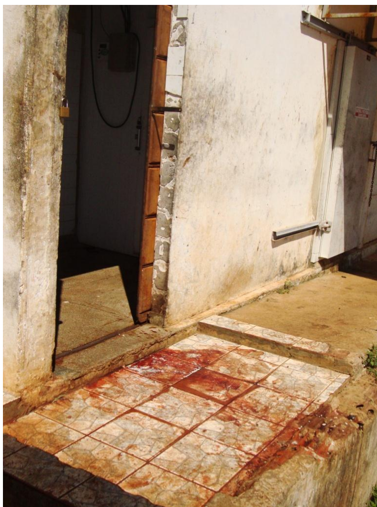
Figura 09: Abatedouro D. Porta de acesso à sala de abate.
