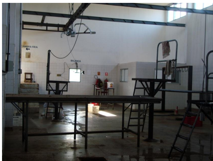
Figura 15: Abatedouro E. Boas condições de higiene e manutenção.
