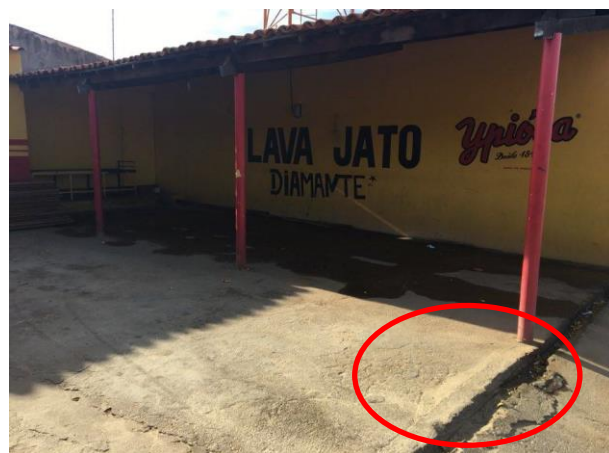
Figura 13 – Lavajato aberto e com solo permeável em Pau dos Ferros, 2016.
