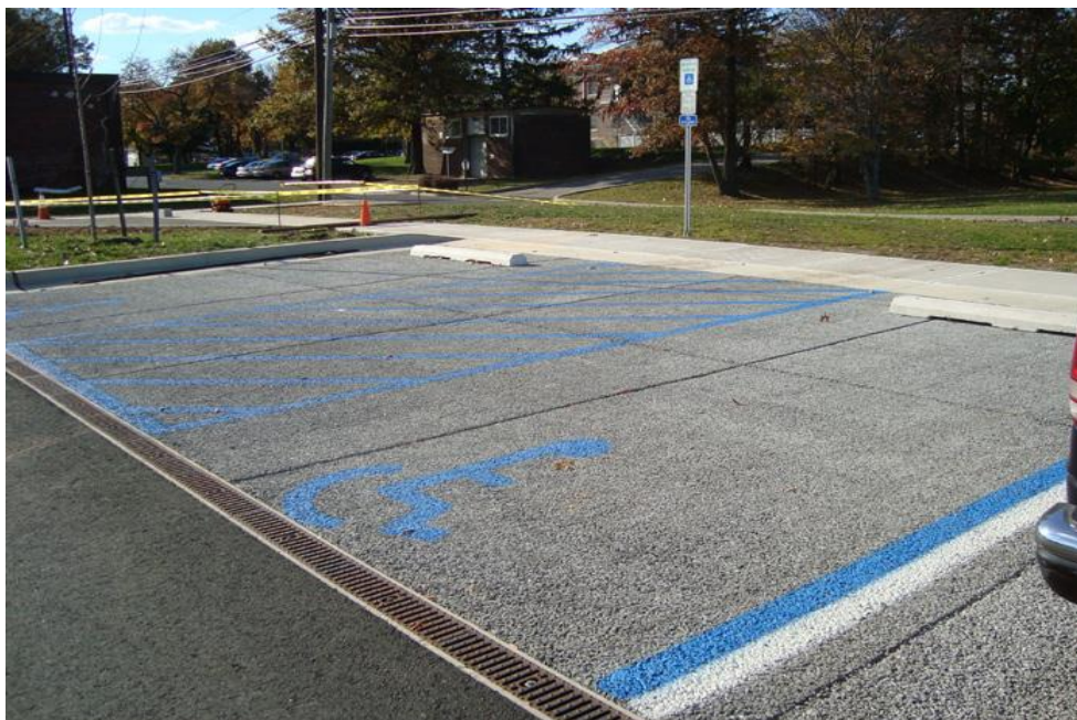
Figura 7 - Pavimento de concreto asfáltico poroso em um estacionamento.
