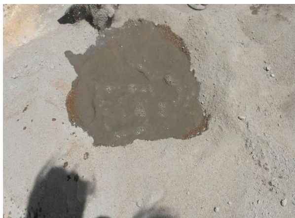
Figura 20: Mistura manual dos materiais para formação da massa de concreto.
