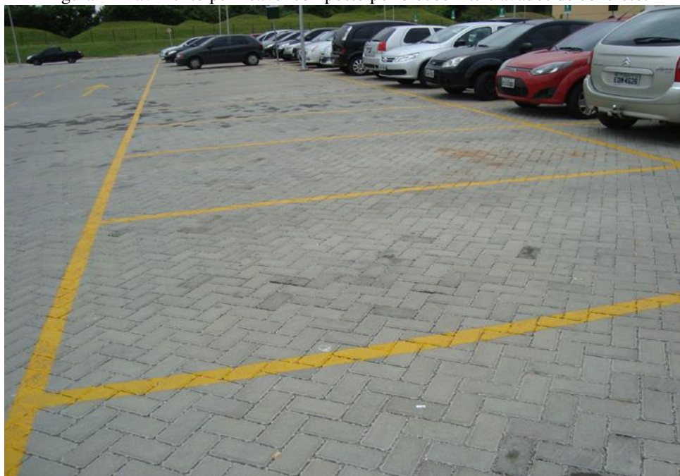
Figura 4 - Pavimento permeável composto por blocos intertravados de concreto.
