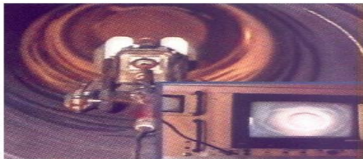
Figura 1 – Inspeção Visual dentro de Tubulação
