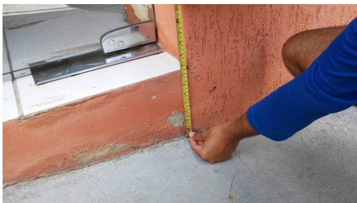
Figura 17- Detalhe do degrau na entrada da secretaria de ação social
