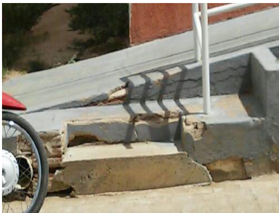
Figura 14- Detalhe da subida da rampa para os prédios das secretarias
