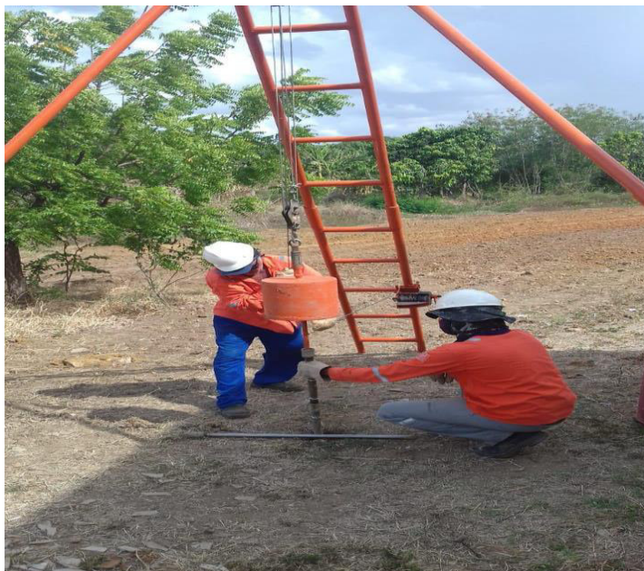
Figura 17 – Cravação do amostrador padrão
