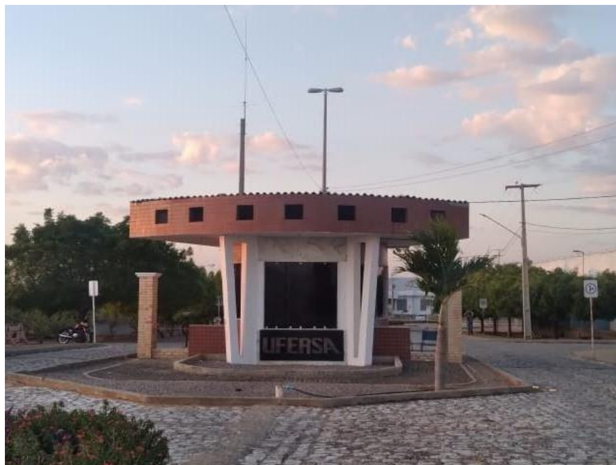
Figura 16 - Fachada da UFERSA campus Caraúbas/RN.
