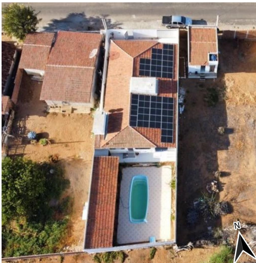
Figura 11 – Imagem aérea do arranjo das placas fotovoltaicas da unidade consumidora nº258 – Usina fotovoltaica de autoconsumo
