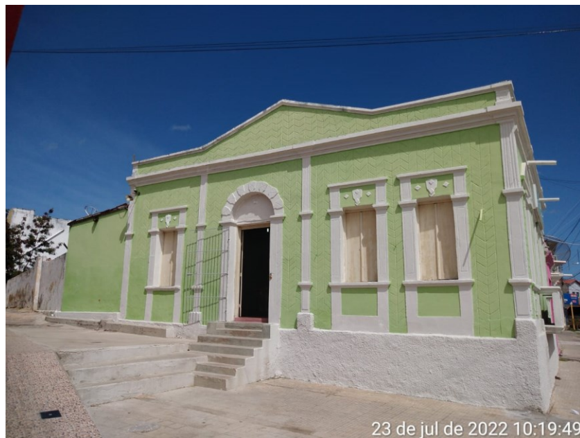
Figura 12 - Fachada lateral esquerda acesso único
