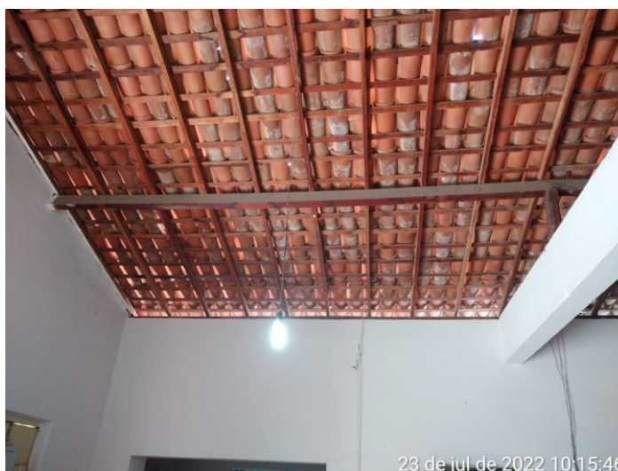
Figura 15 - Peças do Telhado Seladas
