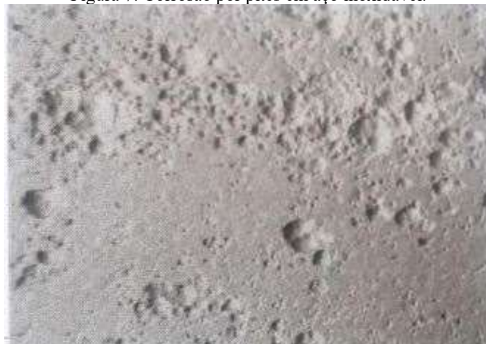
Figura 7: Corrosão por pites em aço inoxidável.
