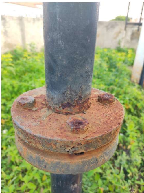
Figura 21: tubulação metálica presente na caixa d'água.
