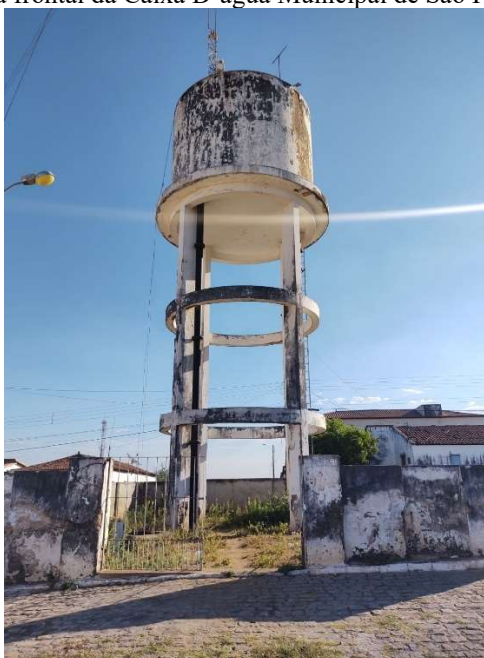
Figura 18: Vista frontal da Caixa D'água Municipal de São Francisco do Oeste.
