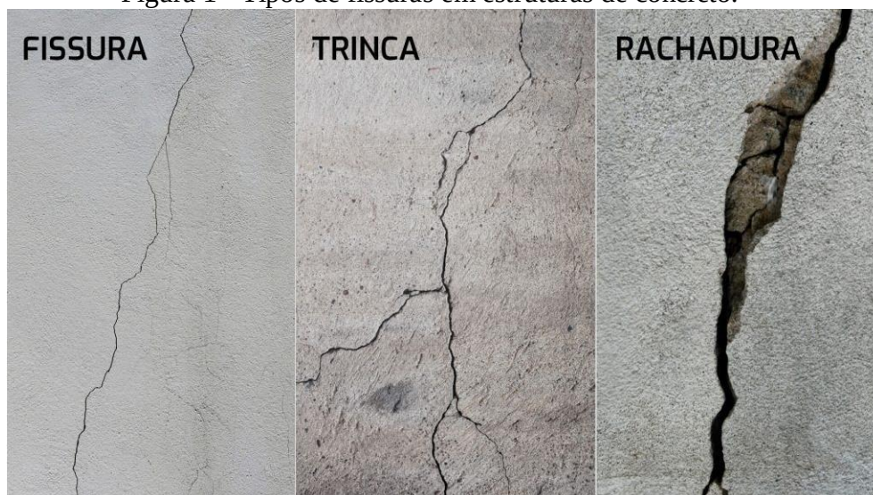
Figura 1 - Tipos de fissuras em estruturas de concreto.
