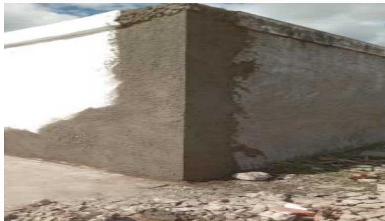
Figura 25 – Aplicação do concreto com argamassa de alta resistência à corrosão.
