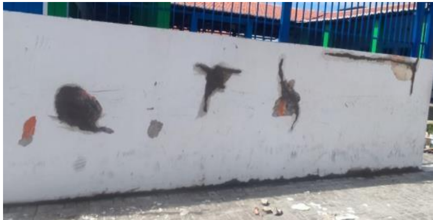
Figura 9 – Correção de trincas e fissuras com de argamassa polimérica de alto desempenho.
