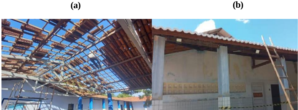
Figura 22 – Revisão em cobertura com telha cerâmica (a) e emboçamento em telhado (b).
