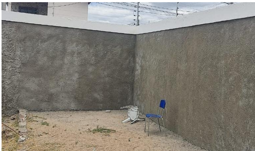
Figura 27 – Aplicação de chapisco decorativo em muro.
