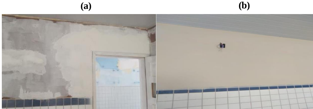
Figura 20 – Aplicação de fundo selador e massa látex (a) e pintura com tinta látex em ambiente interno (b).
