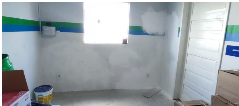
Figura 30 – Aplicação de fundo selador e massa látex em ambiente interno.
