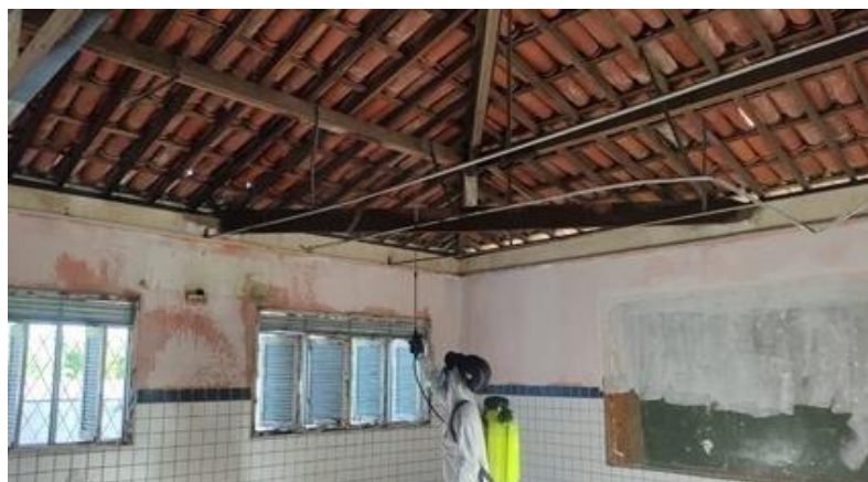
Figura 35 – Imunização de madeira contra cupim.
