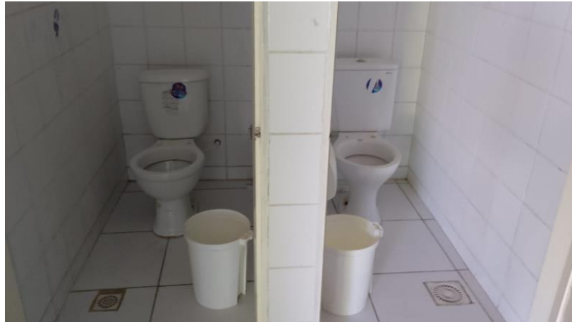
Figura 15 – assentamento cerâmico em banheiro.
