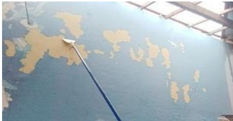
Figura 16 – Raspagem de pintura látex.
