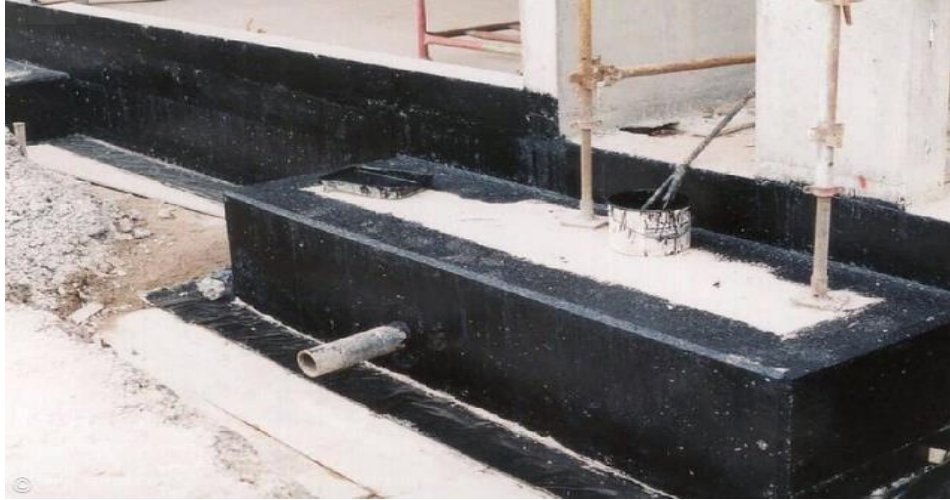
Figura 7 - Aplicação de impermeabilização na base de uma fundação.
