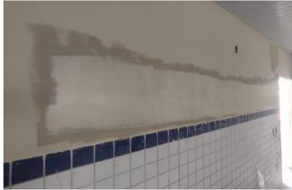
Figura 31 – Pintura com tinta látex em ambiente interno.
