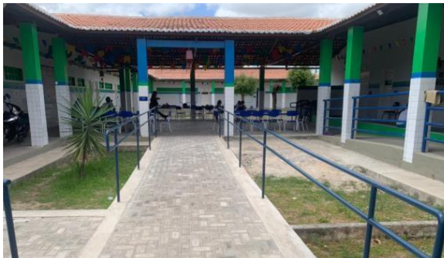
Figura 32 – Pilares do refeitório após a reforma.
