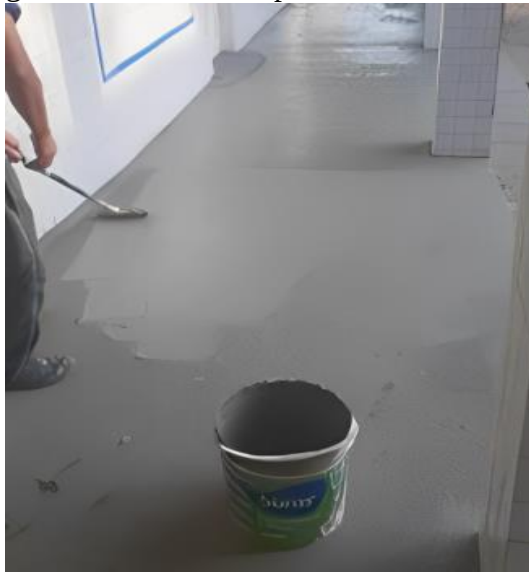
Figura 34 – Pintura de piso com tinta acrílica.
