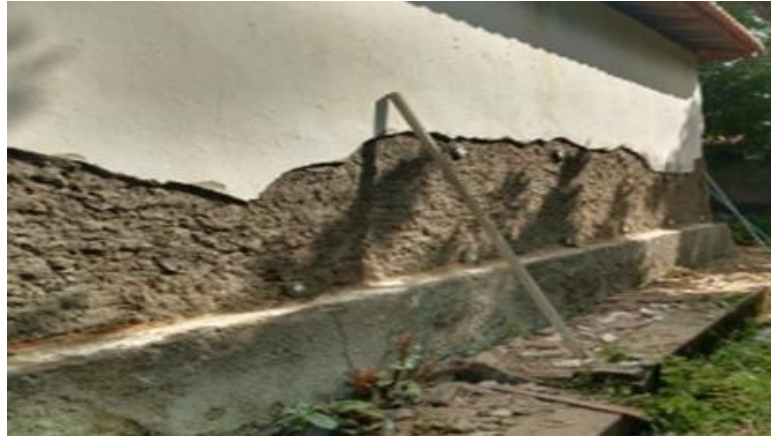
Figura 18 – Aplicação de chapisco com argamassa no traço 1:3.
