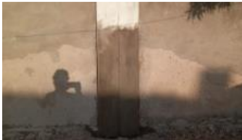
Figura 26 – Aplicação do concreto com argamassa de alta resistência à corrosão em pilar.
