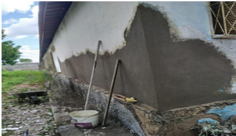
Figura 19 – Impermeabilização de parede com argamassa, usando aditivo impermeabilizante.
