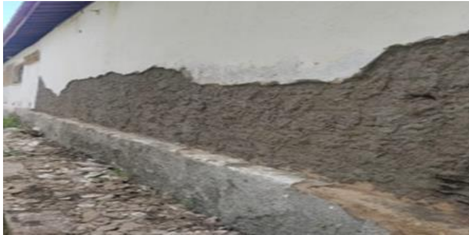
Figura 18 – Aplicação de chapisco com argamassa no traço 1:3.
