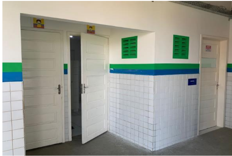
Figura 33 – Parede próxima ao banheiro após a reforma.
