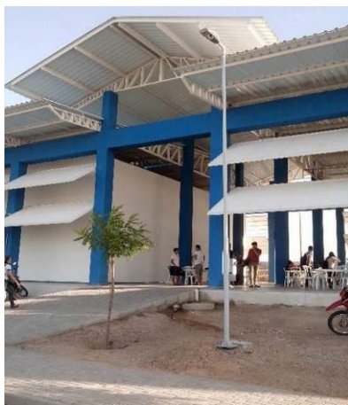
Figura 2 – Poste de iluminação colocada após plantio da árvore nas proximidades do centro de convivência.
