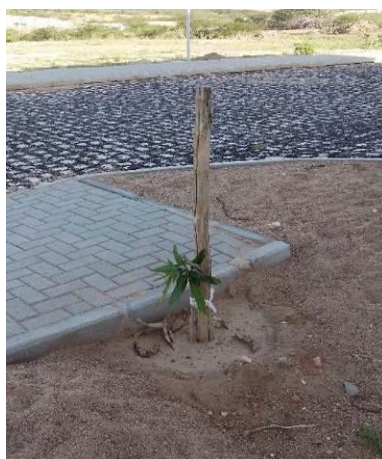
Figura 3 - Árvore plantada com espaçamento inadequado da calçada
