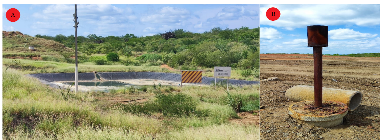
Figura 2 - Aterro Sanitário de Salgueiro - PE. A) Lagoa de chorume; B) Queimador do biogás
