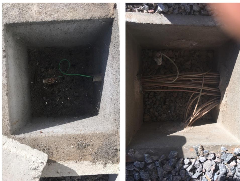
Figure 8 - Conexões dos aterramentos (Autoria própria)
