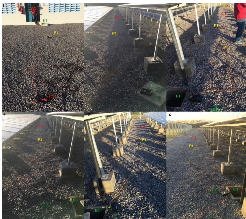
Figura 5 – Execução da medição da resistência de terra (Autoria Própria)
