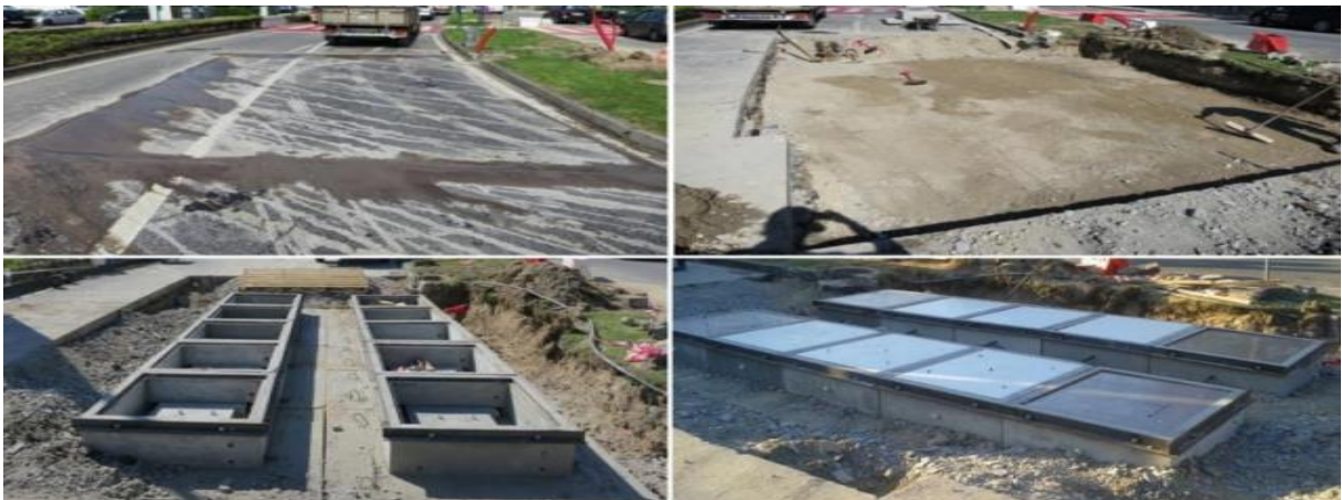
Figura 29: Processo de implantação do sistema Wayenergy Vehicles
