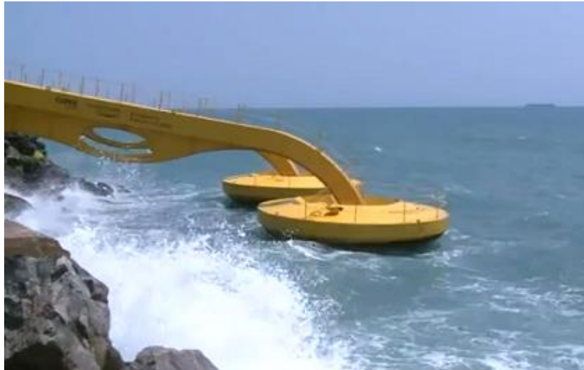
Figura 16: Usina maremotriz do Porto do Pecém (CE)
