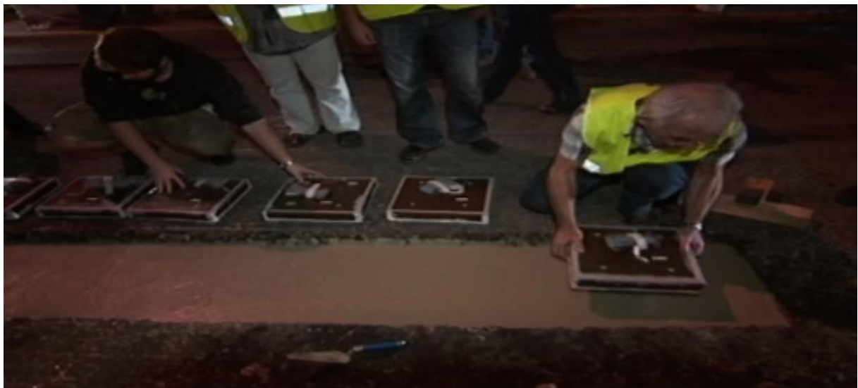
Figura 40: Instalação do material piezoelétrico em estradas, Innowattech .
