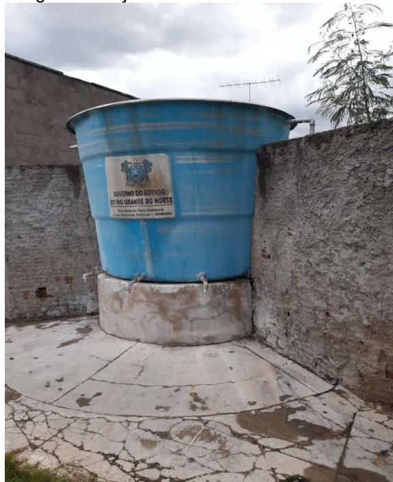
Figura 9: Poço no Bairro Riacho do Meio
