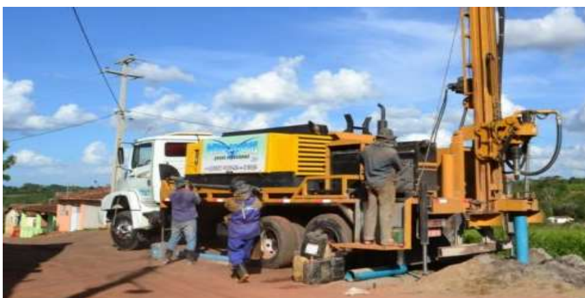
Figura 5: Perfuração de poços.
