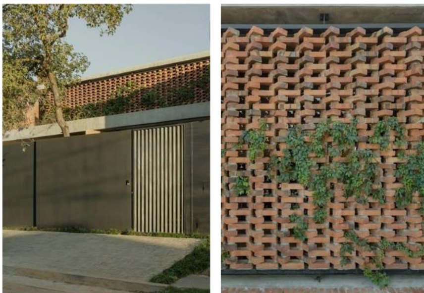
Figura 12 – Parede tijolo semi prensado
