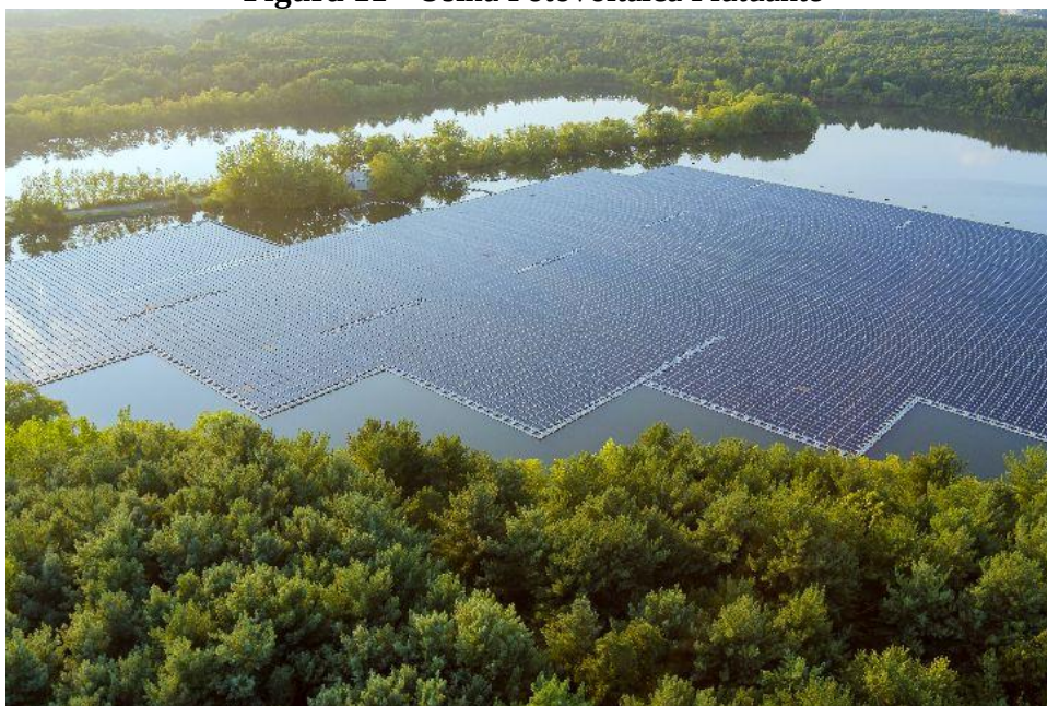
Figura 11 - Usina Fotovoltaica Flutuante
