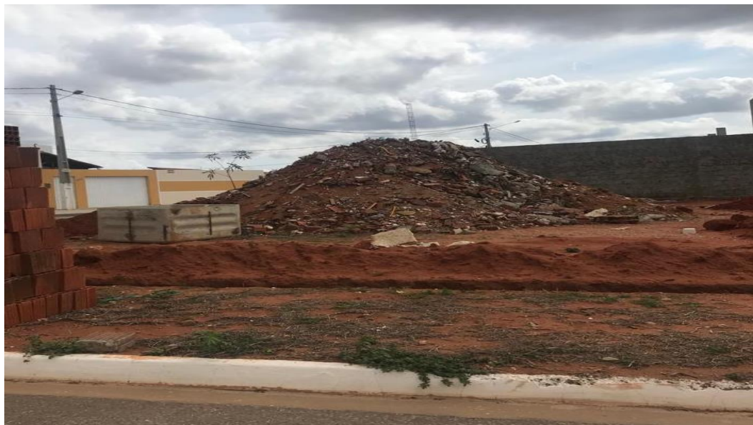
Figura 14: Disposição de RCD em terreno no bairro Sumaré.
