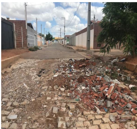
Figura 11: Resíduo da construção civil em via no bairro Bom Jesus
