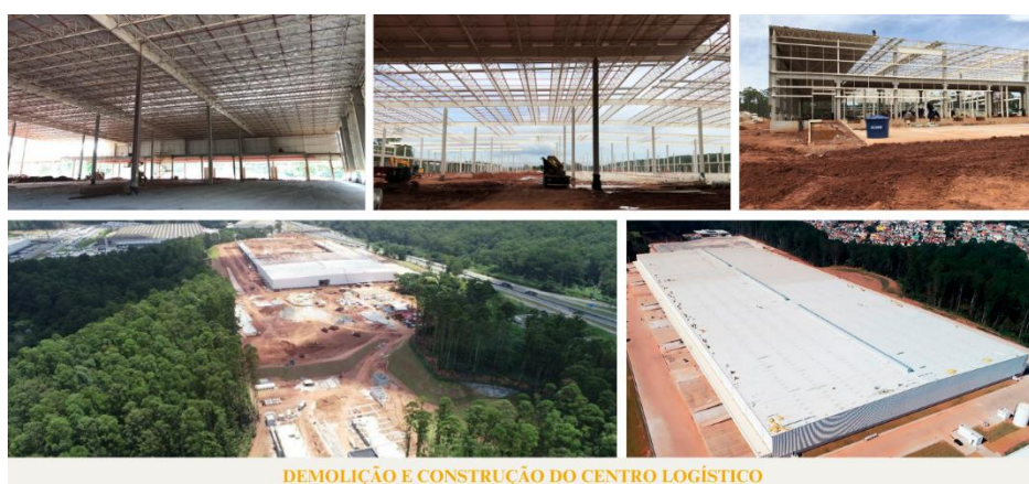
Quadro 7 - Demolição e construção do centro logístico.
