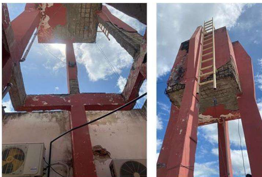
Figura 43 - Inferior e lateral da Caixa D'água
