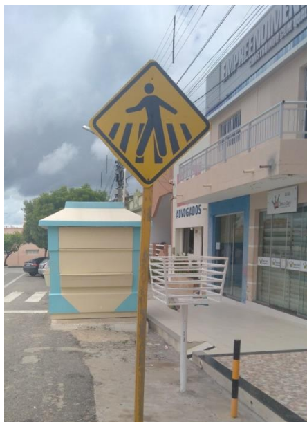
Figura 13 – Placa de atenção sem respeitar a distância limite
