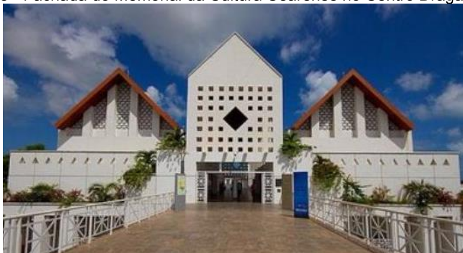
Figura 28 - Fachada do Memorial da Cultura Cearense no Centro Dragão do Mar.
