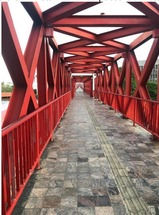
Figura 31 - Vista interior da passarela metálica.
