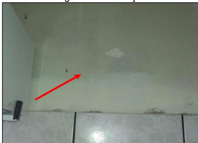
Figura 5 – Infiltração
