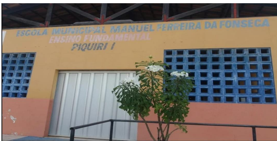
Figura 17: Fachada da EMEF Manuel Ferreira da Fonseca.
