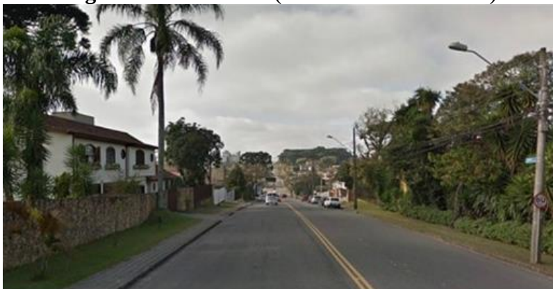
Figura 3: Via coletora (Rua Holanda - Curitiba)
