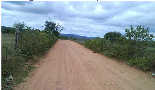
Figura 6: Via rural não pavimentada
