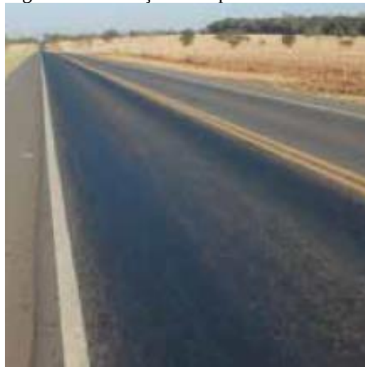
Figura 9: Exsudação na superfície asfáltica.
