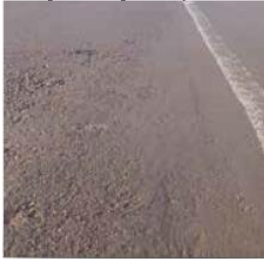
Figura 10: Desgaste da superfície
