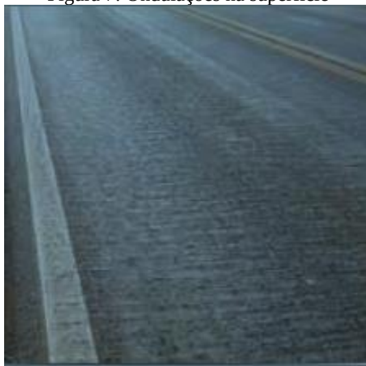
Figura 7: Ondulações na superfície
