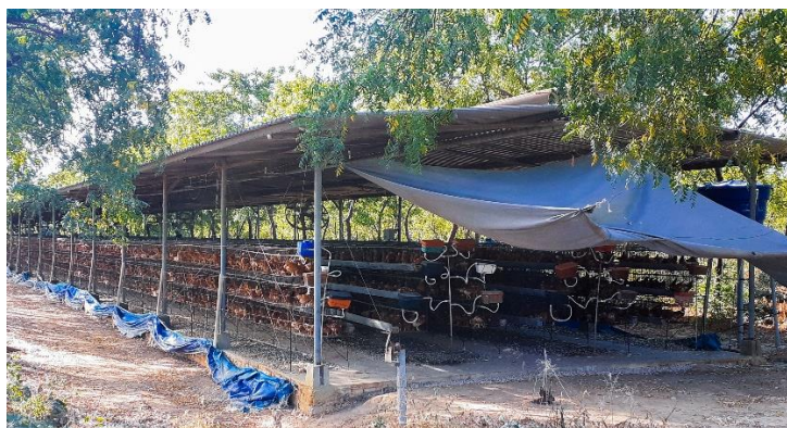
FIGURA 11 - GALPÃO DE RECRIA
