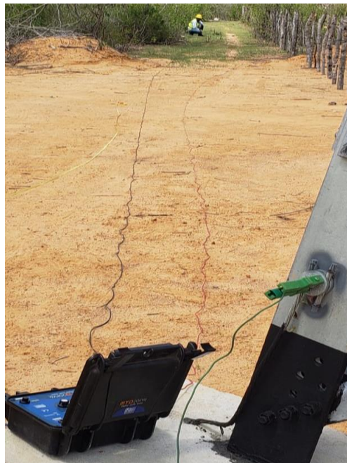
Figura 5 – Realização do procedimento de medição de resistência dos aterramentos
