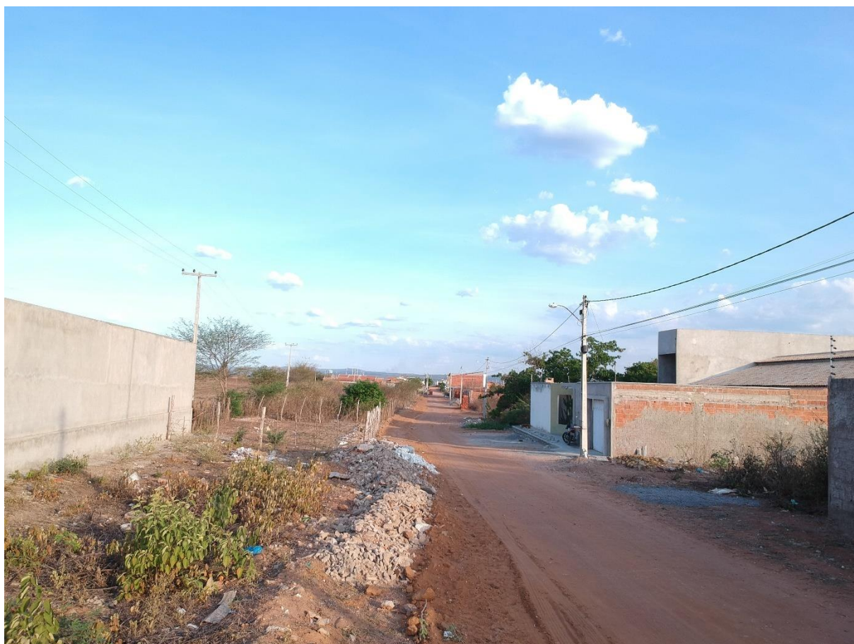
Figura 35: RCC disposto em lugar inadequado no Bairro Bela Vista na cidade de Mauriti – CE
