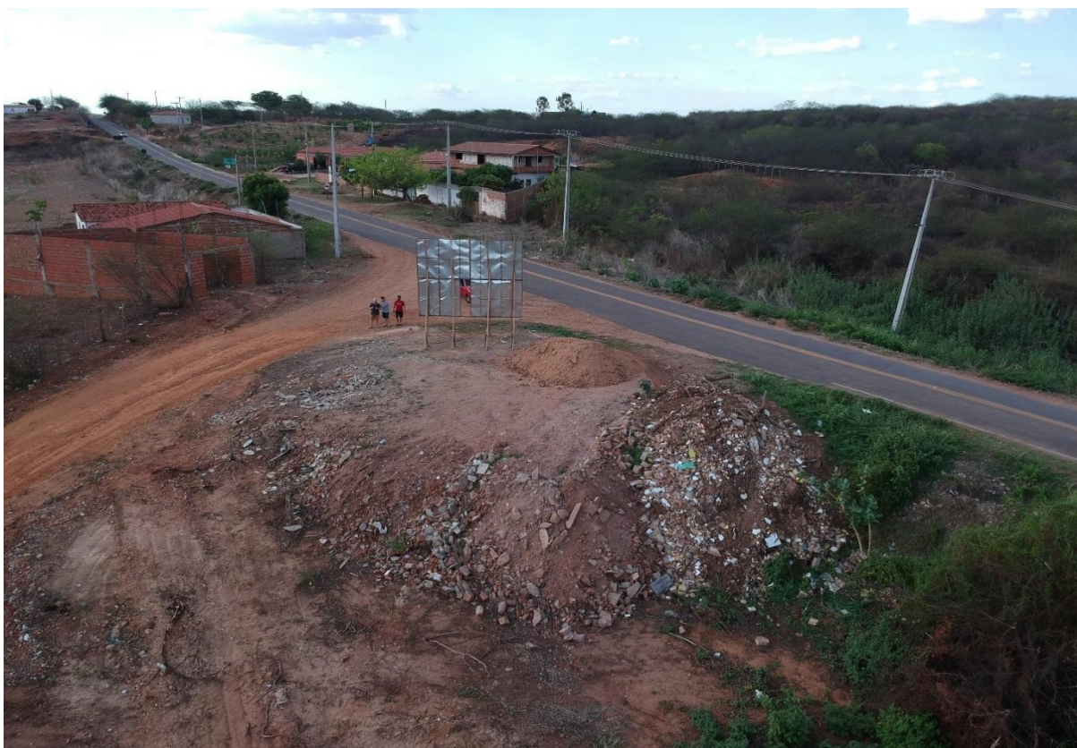
Figura 15: RCC disposto em lugar inadequado ao lado da CE – 152 na entrada do distrito da Palestina
