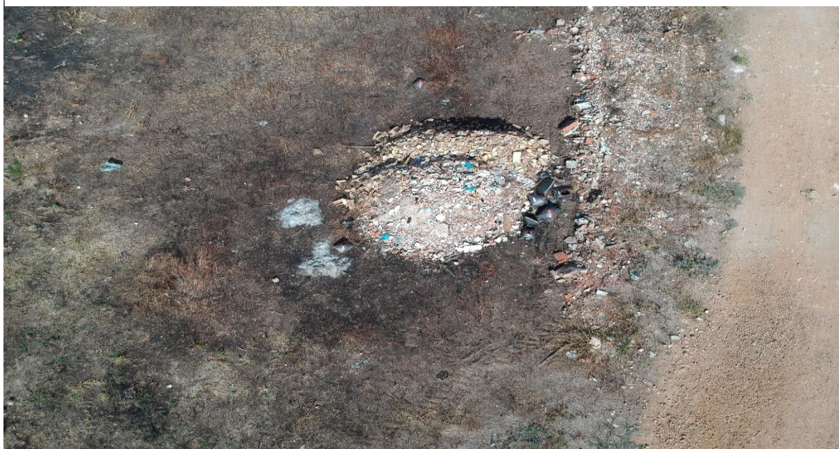
Figura 14: RCC localizado em zona periférica na cidade de Mauriti- CE
